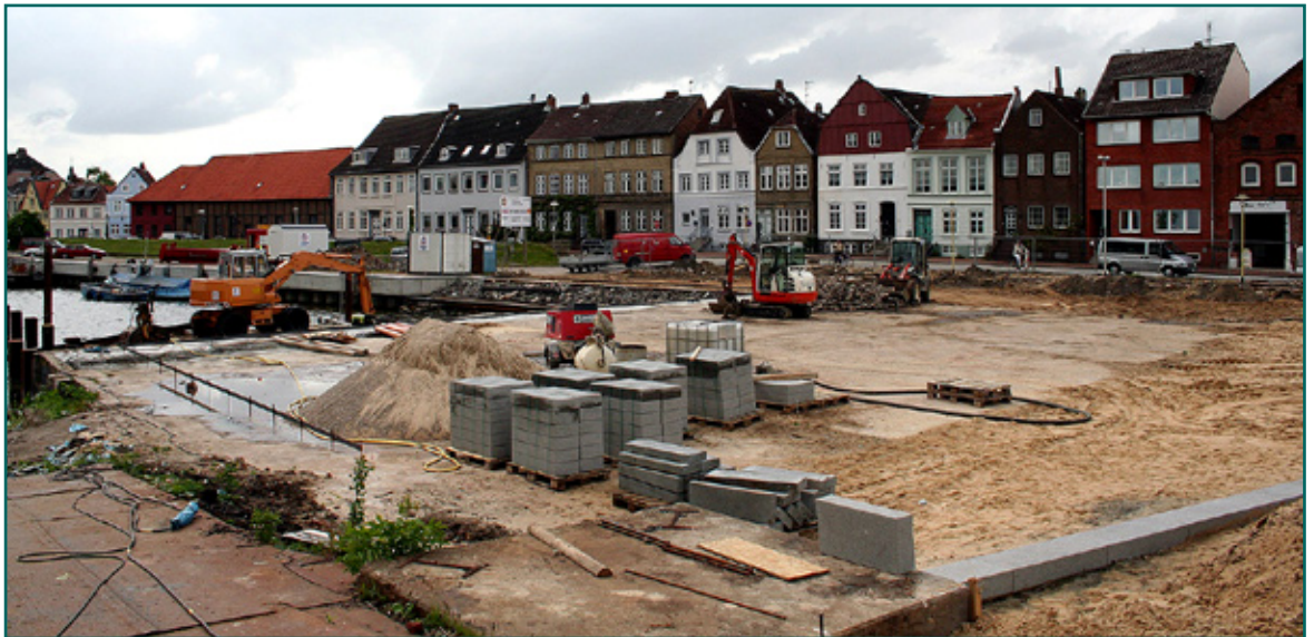
Neugestaltung läuft: Der Glückstädter Hafenkopf erhält ein neues Gesicht.
